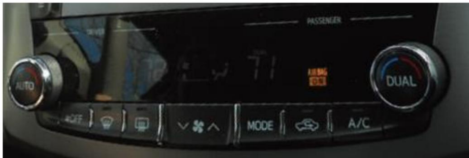
Figura 28. Panel de entrada del operador de HVAC (panel de control).
