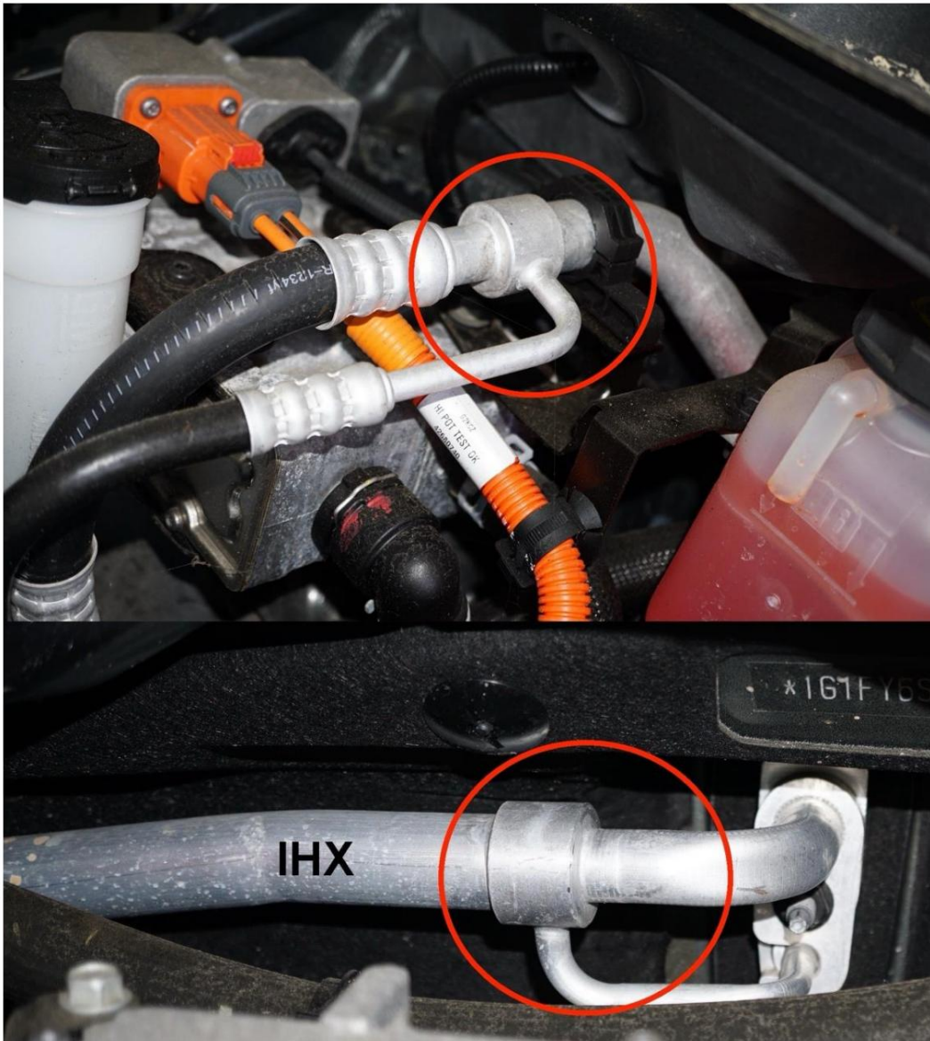
Figura 37. Un intercambiador de calor interno (IHX) se reconoce por las líneas de refrigerante combinadas (encerradas en un círculo).
