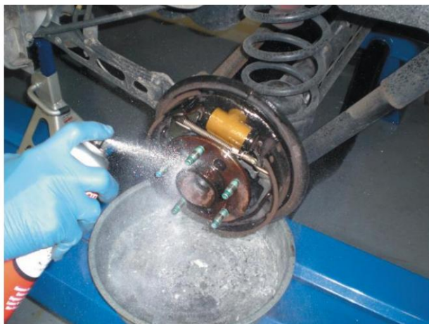
Figura 15. Humedezca el conjunto para atrapar cualquier polvo que pueda contener amianto.
